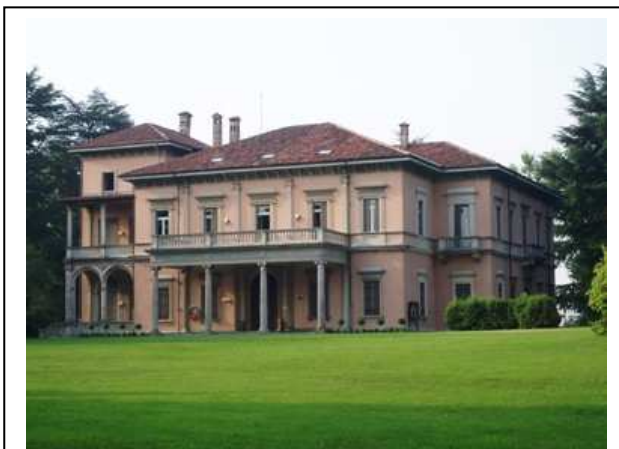
Facciata della Villa Campello
